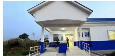
Le site achevé à Porto Loko
