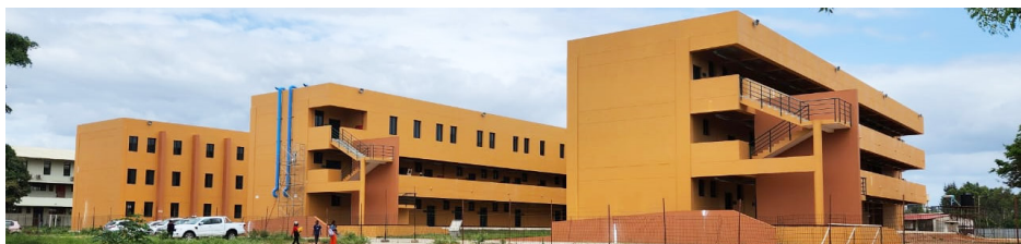
Des bâtiments du Département de Géologie.
