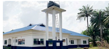
Le site achevé à Porto Loko
