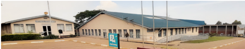
Site de l'hôpital achevé
